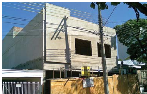
Obras da futura sede própria da Regional de Presidente Prudente
