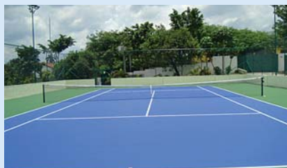
Quadra de tênis do Centro de Convivência de Osasco
